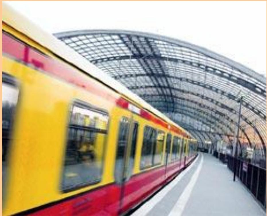
dings nicht so, wie sich die Architekten das vorgestellt hatten. Wesentliches Kennzeichen der Planung war die Überdachung des Gleiskörpers über eine Länge von 450m, der, in einer weiten Parabel geschwungen, von den Bahnhofsgebäuden gequert wird.
